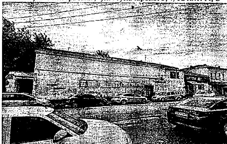
Фото 1. Вид с северо-востока
